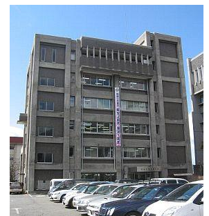
南庁舎 本庁舎に隣接の庁舎 耐震補強 (平成31年度完了)
