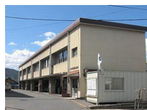
西庁舎 解体し新本庁舎として 一体で建築
