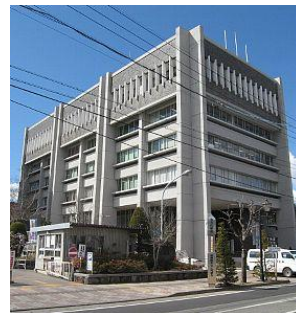
本庁舎 解体し新本庁舎建築 (平成32年度末までの竣工)
